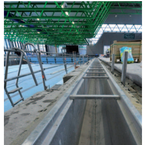
Einzelteile präzise verschweißt: Wie aus einem Guss wirkt die Überlaufrinne des Wettkampfbeckens.
