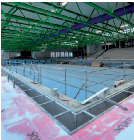
Das Wettkampfbecken im Hallenbad West: 150 Meter Edelstahlrinne wurden hier verbaut.
