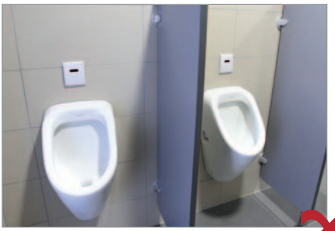
TECE_Urinal.jpg Neuste Technik auch am Urinal: berührungslose Spülauslösung mit Autofokus-Sensor.
