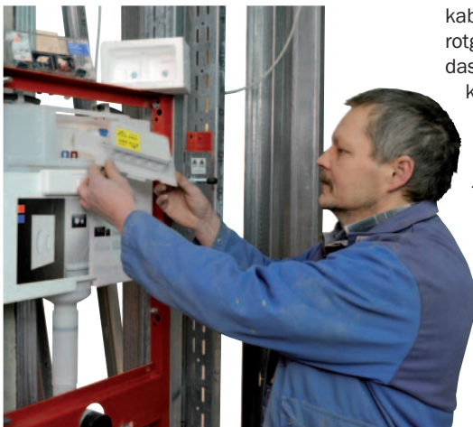
TECE-Gerontomodul: Vorgebohrte Stahlplatten und Leerrohre für Elektrokabel erleichtern die barrierefreie Installation.
