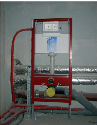
Schnell und einfach installiert – WC-Modul und Spültechnik von TECE.
