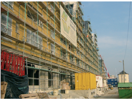
Attraktive Wohnlage – das Siebengebirge, hier noch als Baustelle, liegt direkt am Rhein.
