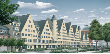
Städtebaulich perfekt eingebunden – so präsentiert sich das umgebaute Speichergebäude zur Stadt hin.
