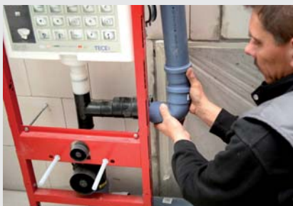
Schnell installiert: Über einen DN-70-Anschluss am Spülrohr wird das WC-Modul an die Lüfterleitung angeschlossen.
