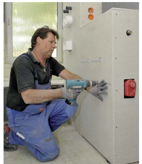
Fertig verplankt: Jetzt kann der Fliesenleger kommen.
