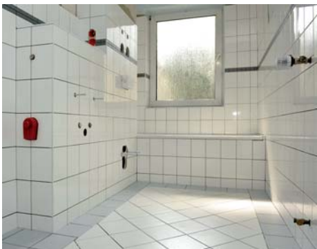
Neues Bad: Dank vorkonfektionierte Sanitärwände mussten die Mieter nicht lange darauf warten.
