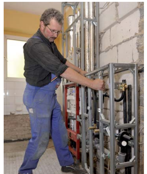
Passt perfekt: Das zweite Register wird aufgestellt und mit dem ersten verbunden.
