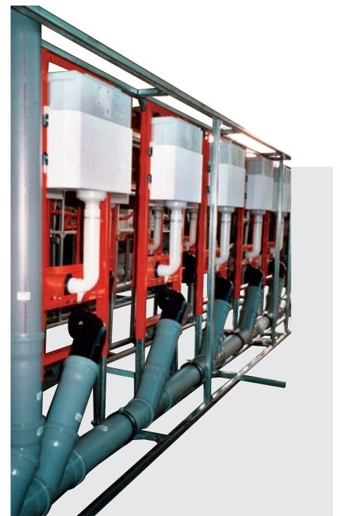
Die anschlussfertigen Sanitärwände wurden in die Betonfertigteile des Stadions integriert.
