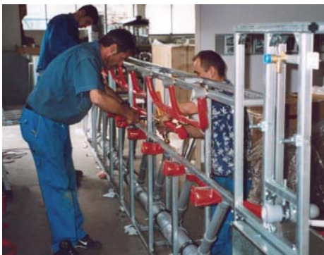
In der eigenen Werkstatt montierte das Schomberg-Team 32 anschlussfertige Sanitärwände.
