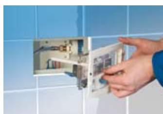
Im Servicefall kann die komplette Technikeinheit mit Hebelmechanik, Deckel und Befestigungsplatte entnommen werden. Alle Einstellungen bleiben erhalten.
