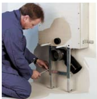
Einfache Montage: Standfüße und Befestigungswinkel sind variabel.
